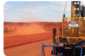
mecánica de suelos
